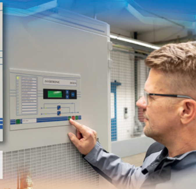
Abb. 4: In der frontseitigen Anzeigen- und Bedieneinheit befinden sich die Funktions- und Störmelde-LED's, Bedienungstaster und ein Blindschaltbild.
