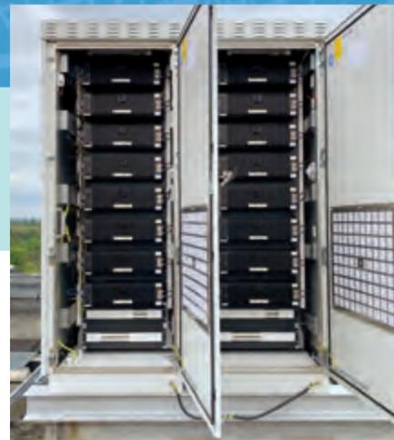
soll sich der Stromspeicher innerhalb von nur 26 Stunden wieder vollständig aufladen lassen, was BENNING durch den Einsatz von drei SLIMLINE Gleichrichtern mit je 3000 W Leistung umsetzte.
