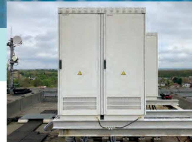
Das neue System wurde Rücken an Rücken auf der bestehenden Plattform des alten Stromversorgungscontainers installiert. Gut zu erkennen ist der geringe Footprint des neuen Systems im Vergleich zur alten Plattformbasis
