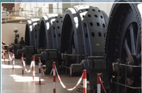
Facelift für Laufwasserkraftwerke 20–29
