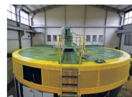
Der Generator nach Abschluss der Remontage im Laufwasserkraftwerk Harrbach
