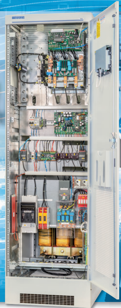
Figura 2: Vista interior de rectificador THYROTRONIC
