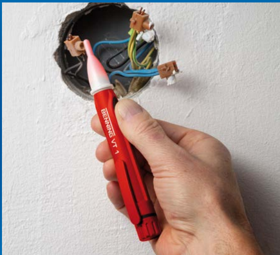
Phasenprüfung an Abzweigdose mit BENNING VT 1
