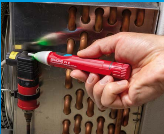
Prüfung eines Magnetventils mit BENNING VT 2
