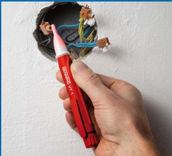
Phasenprüfung an Abzweigdose mit BENNING VT 1
