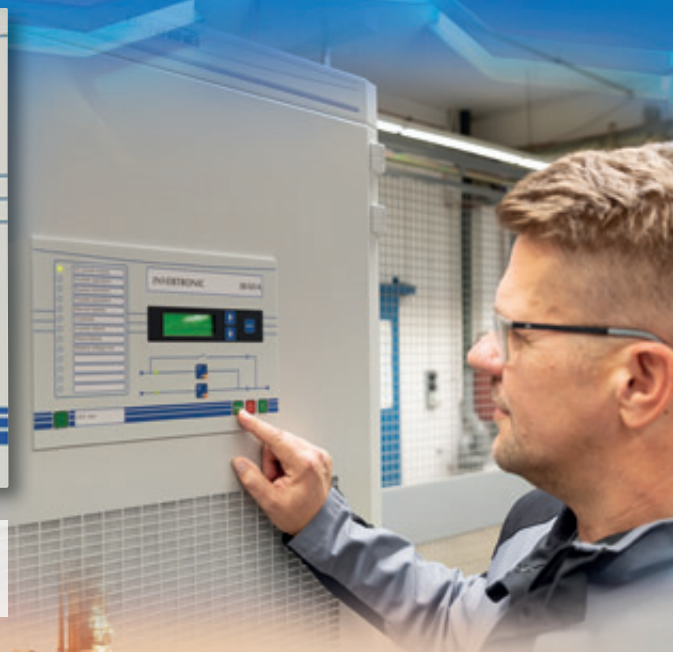
Рис. 4: На дисплее передней панели есть функциональные и предупреждающие о неисправностях светодиоды, управляющие переключатели и мнемосхема.
