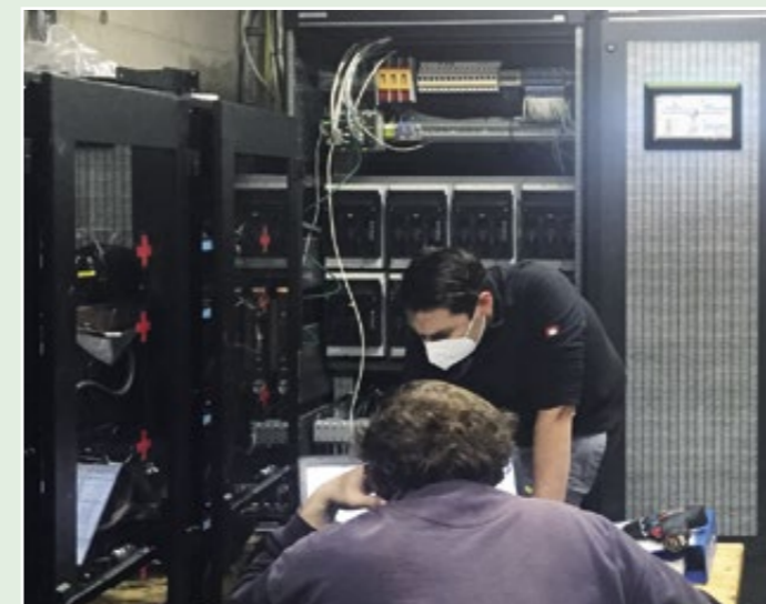
Smarte Vernetzung eines bereits vorhandenen EMS vom Typ S7 mit den neuen Komponenten.
