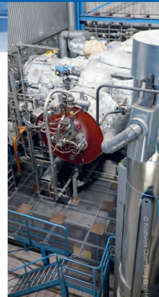
Die Brennstoffzufuhr an der Gasturbine im Bereich des Turbinenläufers
