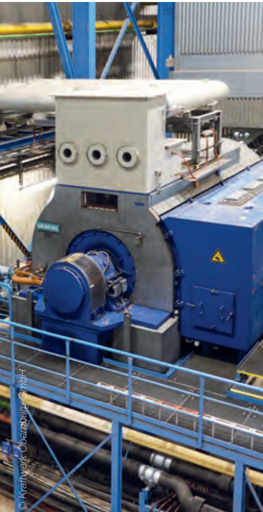
Generatorteil der 60 MW Gasturbine
